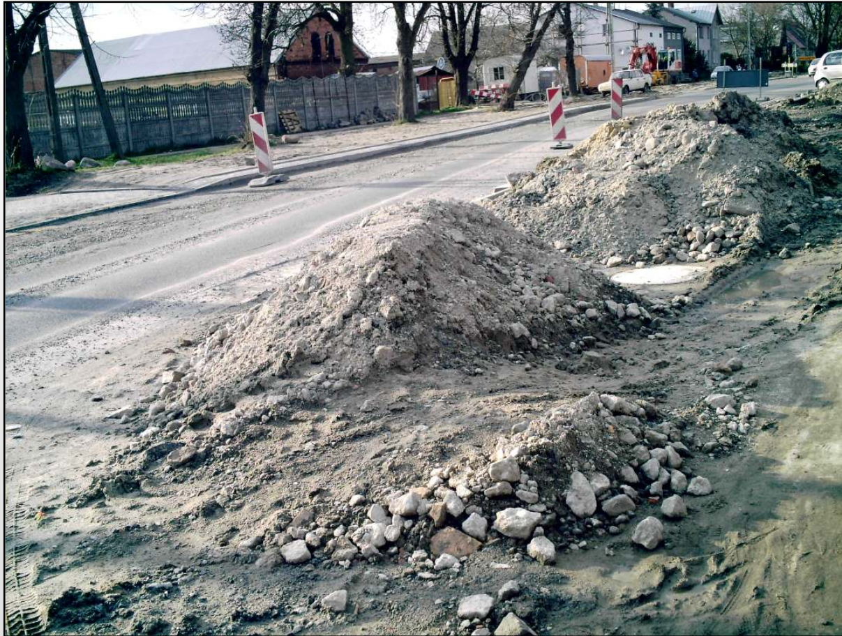
Zostawiona stara rura wodociągowa (2/3)
