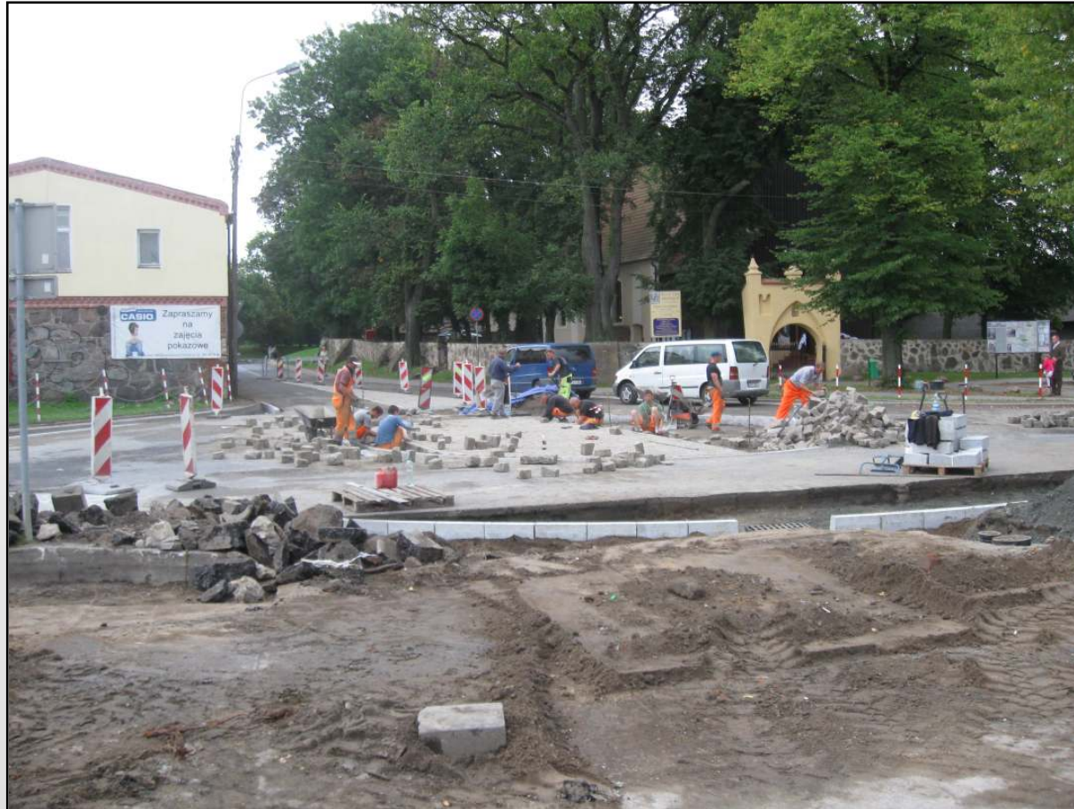
Budowa mini-ronda Szeroka-Żołnierska (sierpień 2011 r.)
