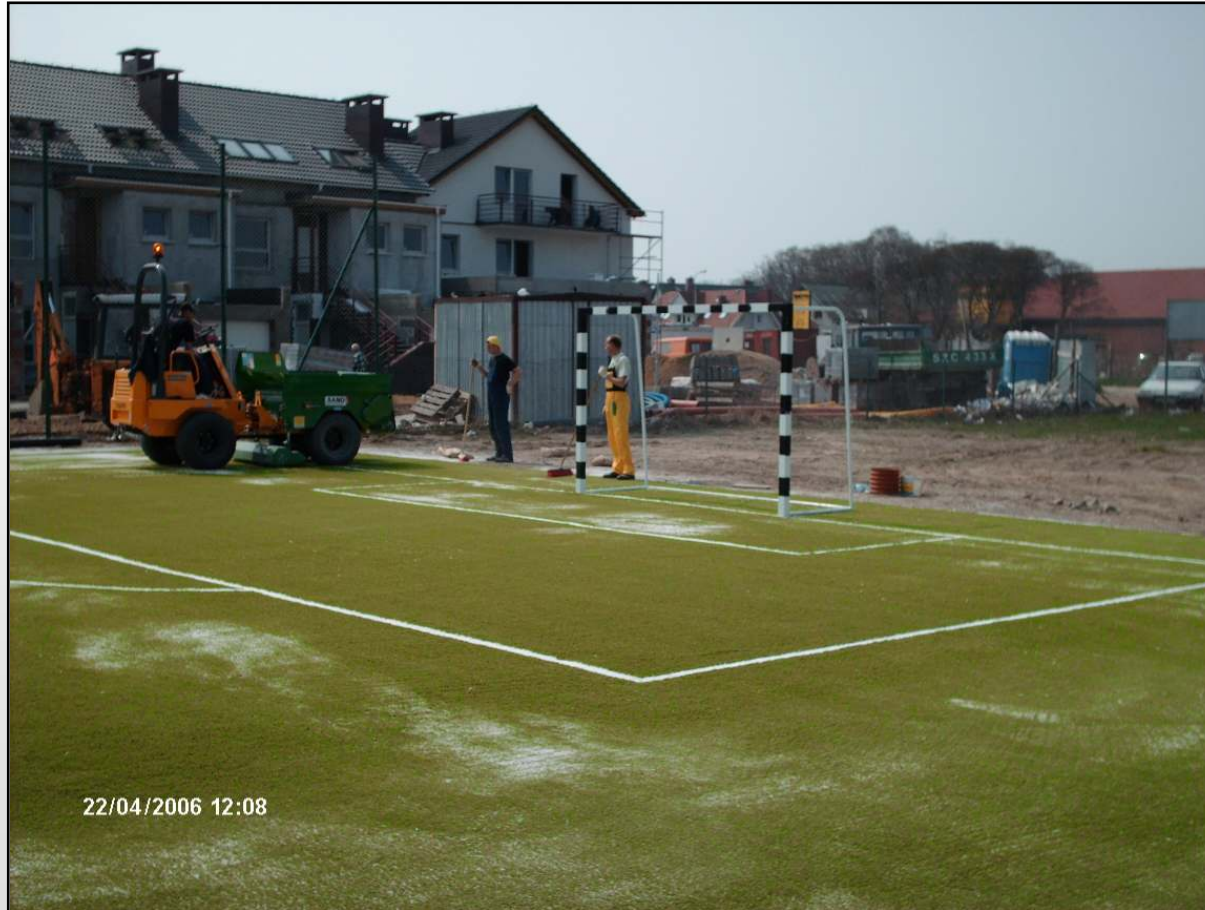
Budowa boiska w 2006 r. (4/6)
