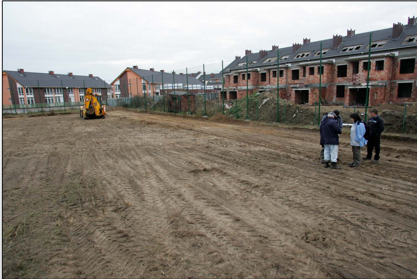
Budowa boiska w 2006 r. (3/6)
