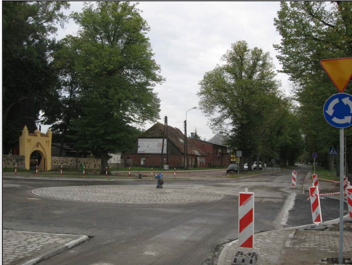
Budowa mini-ronda Szeroka-Żołnierska (sierpień 2011 r.)
