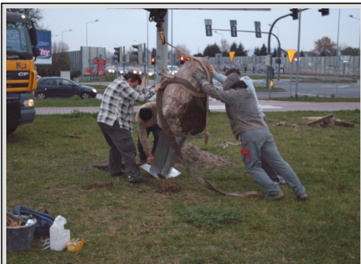
Wtorek, 19 listopada 2013 r. - trwają prace związane z przesunięciem oraz podwyższeniem obelisku upamiętniającego gen. Sosabowskiego
